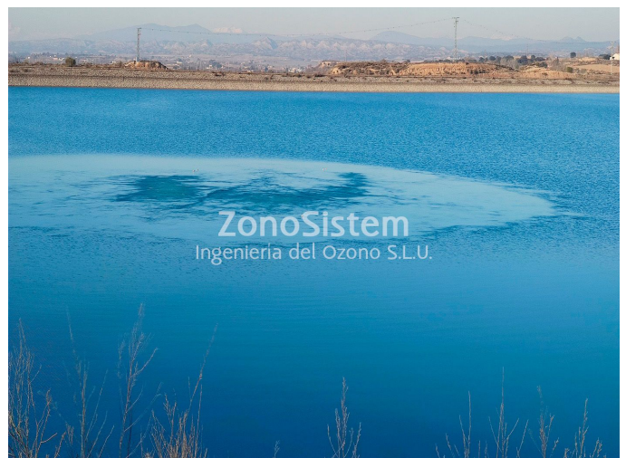
Detalle de burbujeo de ozono en zona de captación de agua. Huesca
