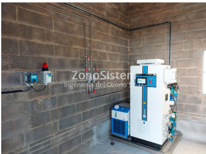
Sala técnica con generador de ozono balsa contaminada con mejillón cebra. Huesca
