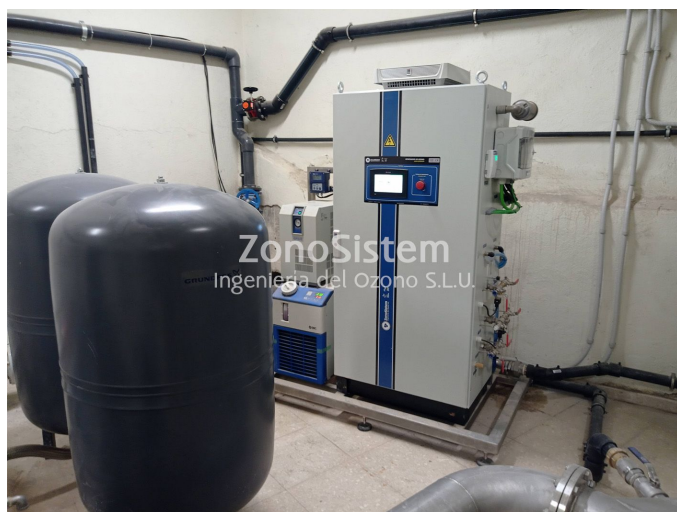
Desinfección de aljibe de agua de riego Santiago Bernabeu. Madrid. España.
