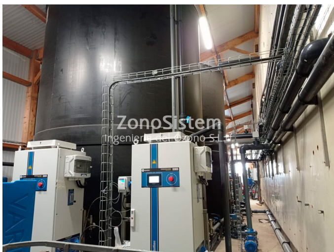
Desinfección de depósitos de tanques de riego. Francia.
